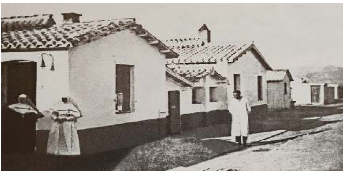
Fig.70 Cagliari, Poetto. Colonia marina. Padiglioni in muratura
