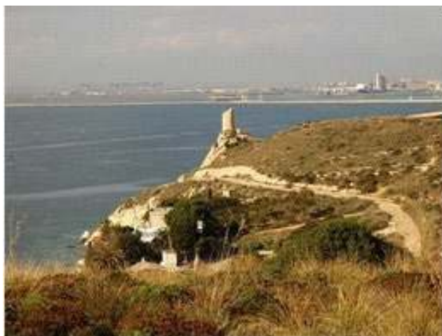
Fig. 60 Cagliari, monte Sant'Elia, Torre Spagnola
